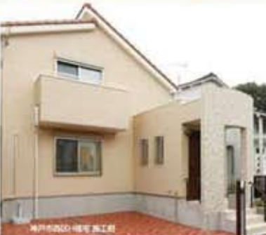
神戸市250-1000号 施工例
