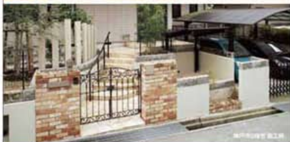
神戸市1000号 施工例
